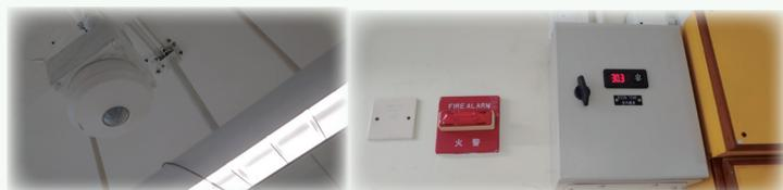
▲ 全校空調安裝電力監察系統(EMU)及動力偵察裝置，打造節能減碳的智能校園。
